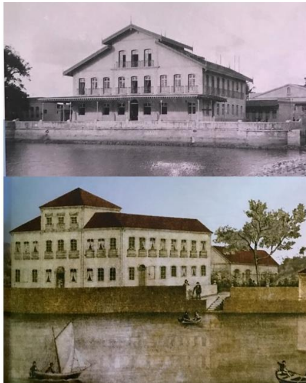
Figura 5. Observe a grande semelhança da casa do Comendador Luiz Gonçalves da Silva com o Grande Hotel Internacional. Ao comparar nota-se que houve uma intervenção nos telhados, uma varanda foi também construída em direção ao rio na parte oeste do hotel e uma nova edificação aparece ao sul. Desenho encontrado no álbum de Luis Krauss de 1878 com uma foto do hotel anos depois (circa 1889).
